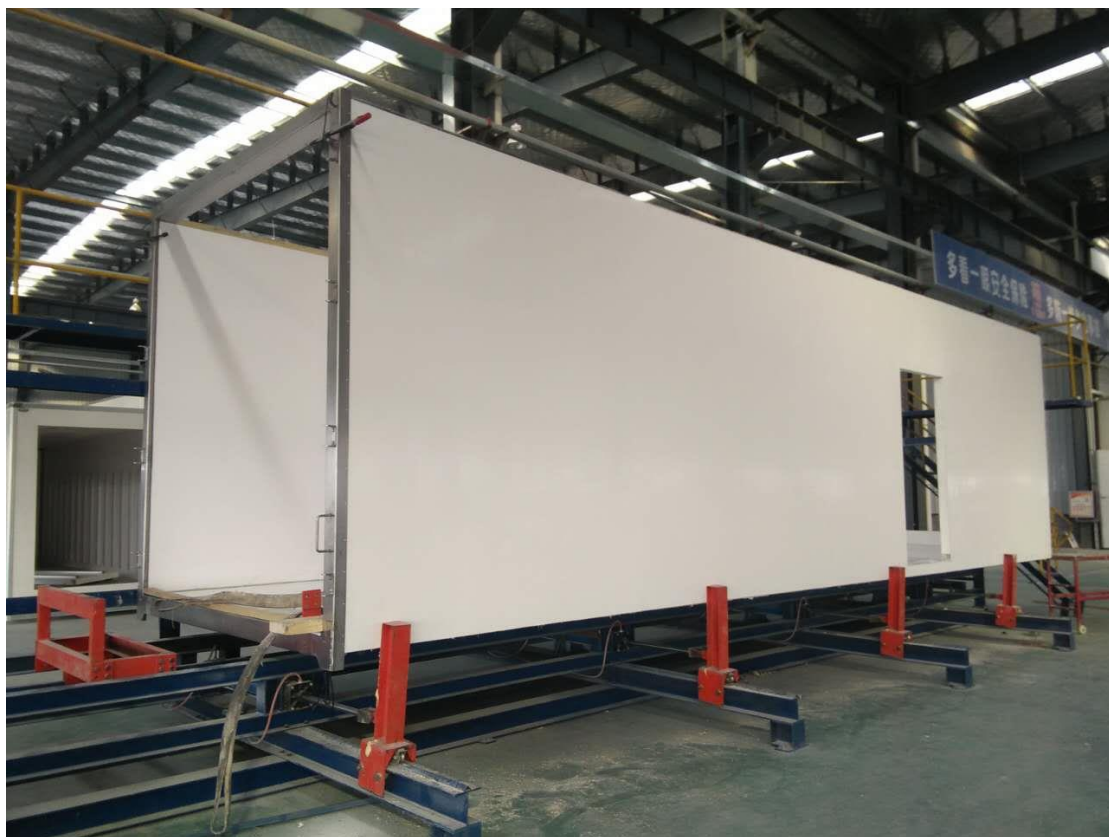
C 型组装架车厢组装中
