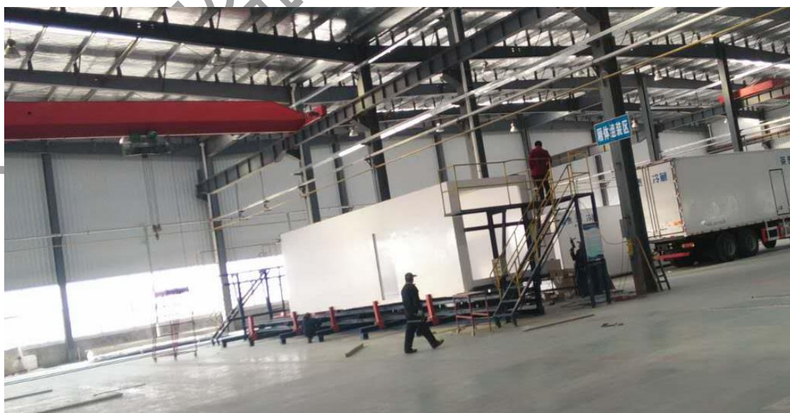
C 型组装架车厢组装中
